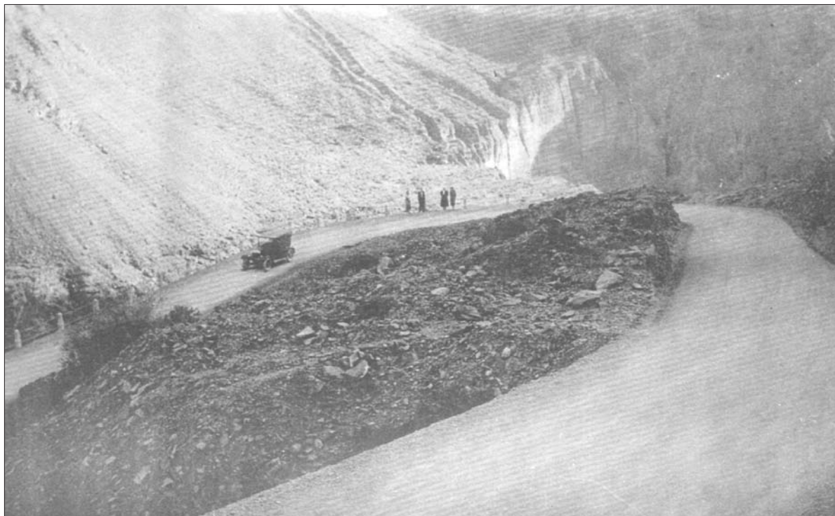
El camino a Calingasta fue íntegramente realizado durante la gestión de Federico Cantoni. Pero los estudios previos y la decisión de hacerlo siguiendo el recorrido del río San Juan fue obra de Jones quién consideró estratégica la construcción de ese camino para integrar los valles cordilleranos
