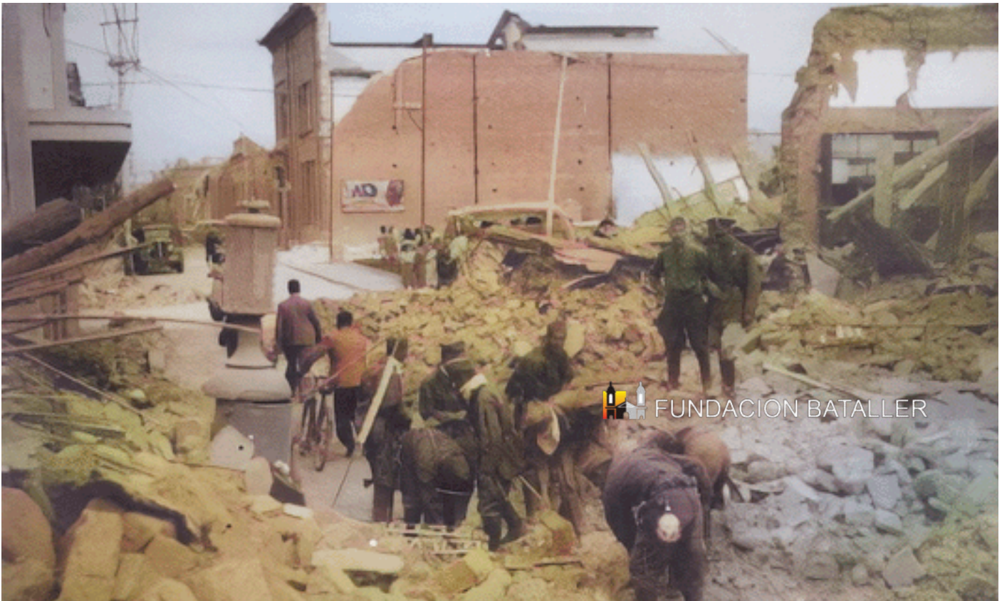
Efectivos del Ejército, en las tareas de despejar y remover los escombros. A la izquierda se aprecia un surtidor de gasolina.
