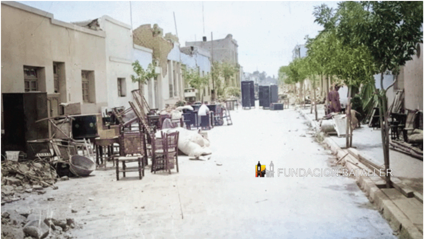
Una de las tantas calles del San Juan afectado por el terremoto. Se despejó la calle de escombros y los habitantes de las diferentes casas, pueden sacar los pocos muebles que se salvaron.
