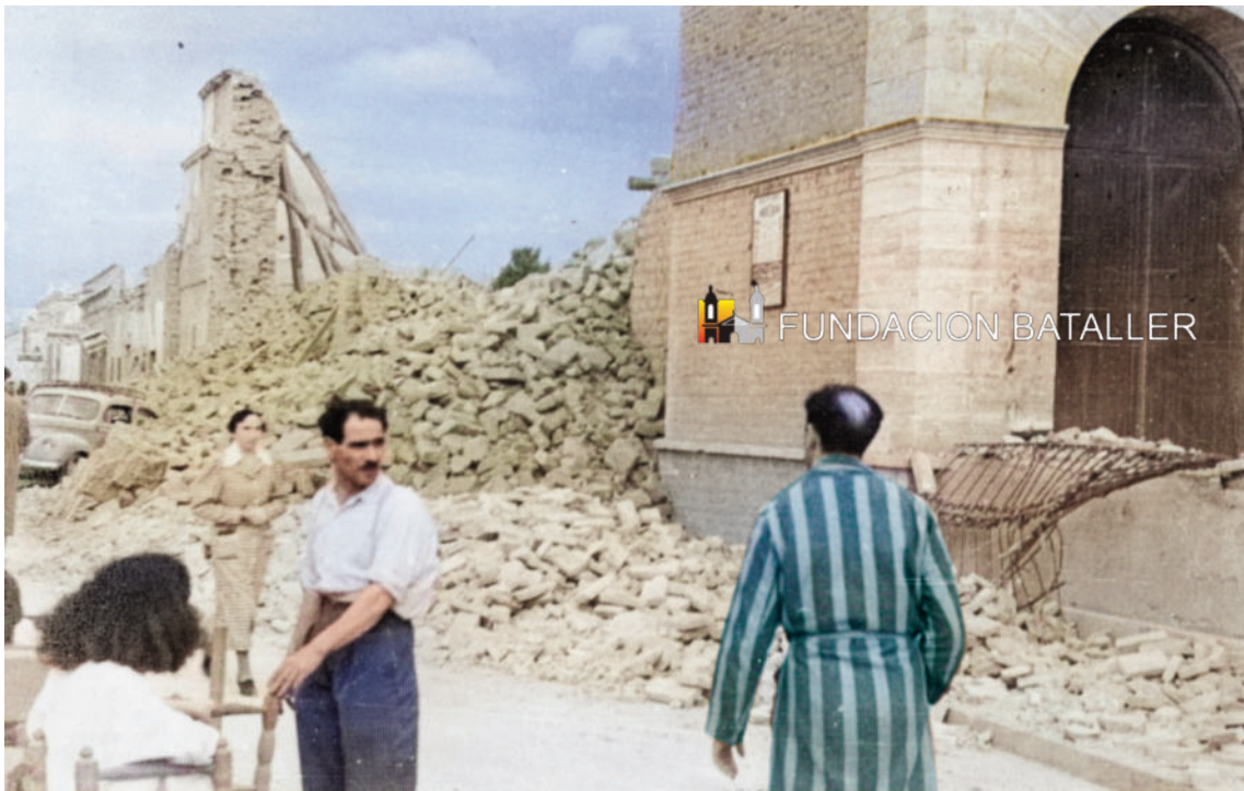
Calle Mitre casi esquina Mendoza. La ciudad de San Juan muy poco después del terremoto del 15 de enero de 1944. Un transeúnte deambula con su bata puesta. Otro hombre, con sus muebles en la calle, lo observa. Atrás, el paredón de la Iglesia de San Agustín sostenido por palos. (Foto publicada en el libro "Y aquí nos quedamos", edición dirigida por Juan Carlos Bataller)
