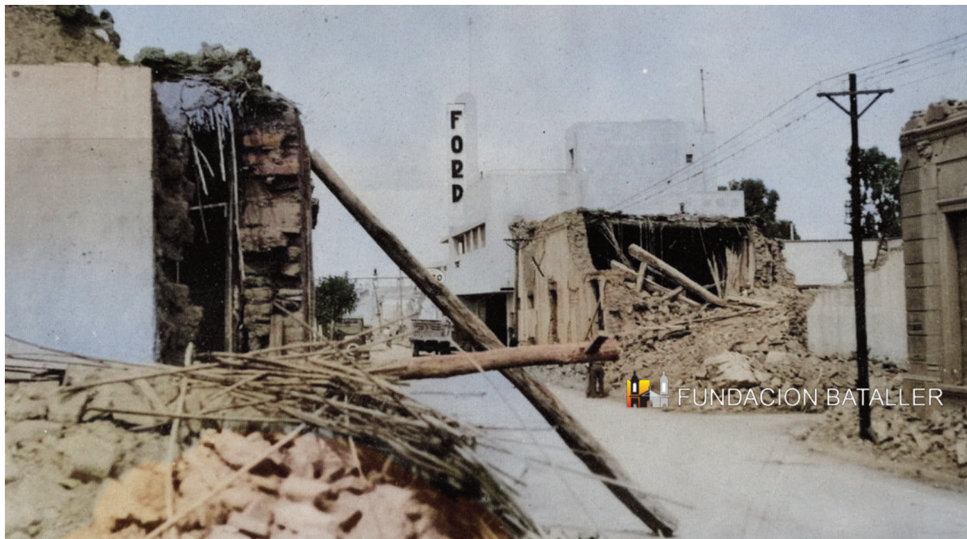
Calle Laprida, en pleno centro de la ciudad de San Juan en 1944. Pueden observarse las deficientes construcciones que existían en la época. Palos atravesados intentan sostener los muros a punto de derrumbarse luego del sismo del 15 de enero de 1944. (Foto publicada en el libro "Y aquí nos quedamos", edición dirigida por Juan Carlos Bataller)
