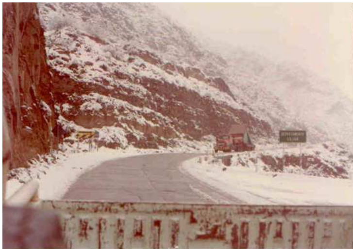
Figura 93 Ruta 7 Mendoza - Uspallata en el Dto. Lujan
