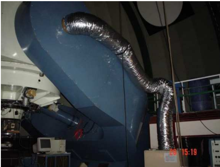
Figura 285 Introducción del aire frío en la celda del espejo a través del eje de declinación
