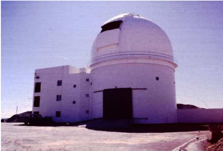
Figura 81 Edificio albergue del telescopio visto desde el sur
