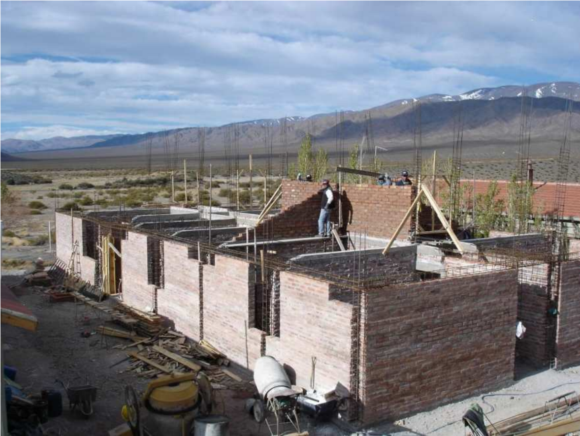
Figura 362 El avance del segundo módulo de dormitorios
