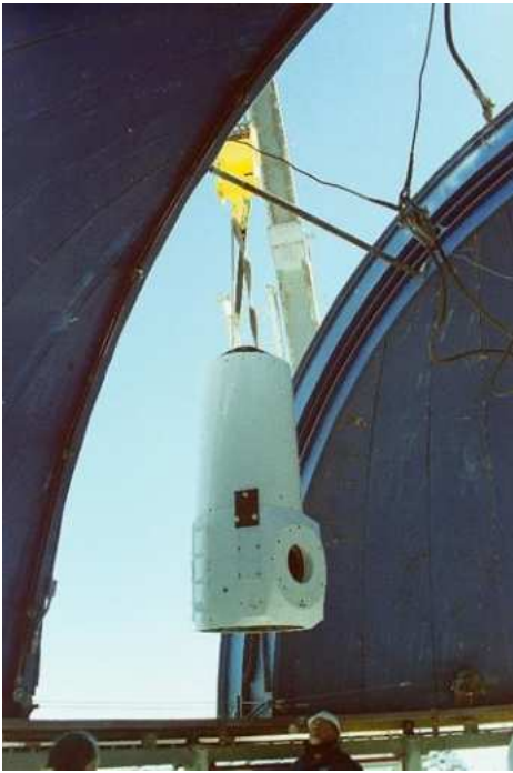
Figura 343 Telescopio introducido en el edificio albergue
