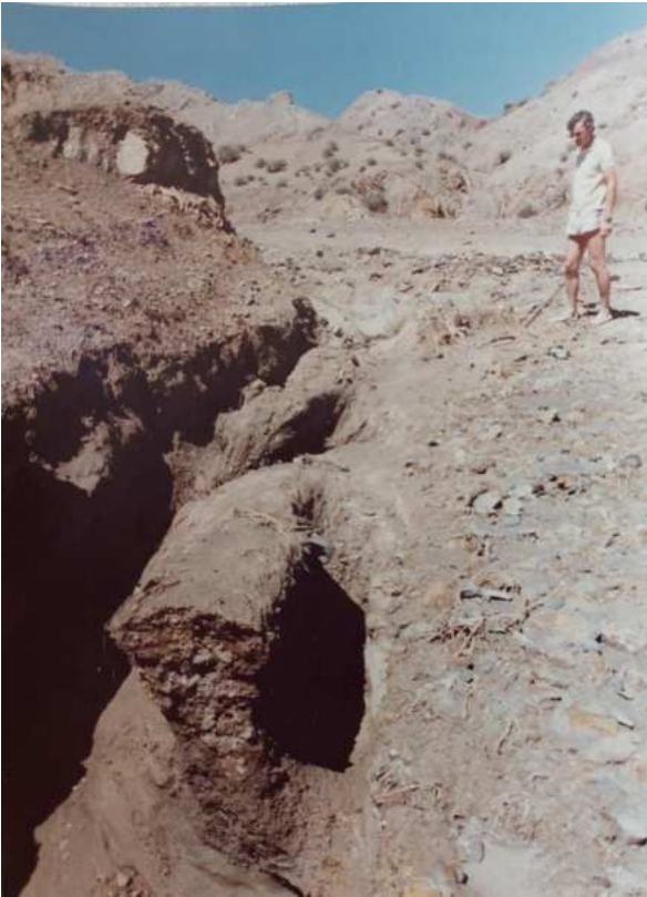
Figura 380 Rotura del primer puente de acceso
