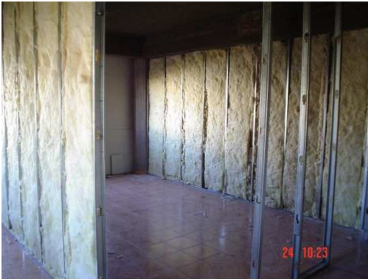
Figura 238 Con estos materiales se realizaron las divisiones de los distintos ambientes
