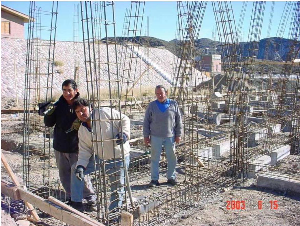
Figura 361 Gabriel Sanchez, Juan Yapura y Carlos Dominguez trabajando en la estructura de uno de los módulos de dormitorios
