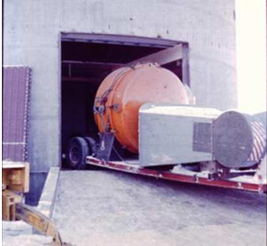
Figura 96 Ingreso de horquilla y campana al edificio del telescopio para su descarga
