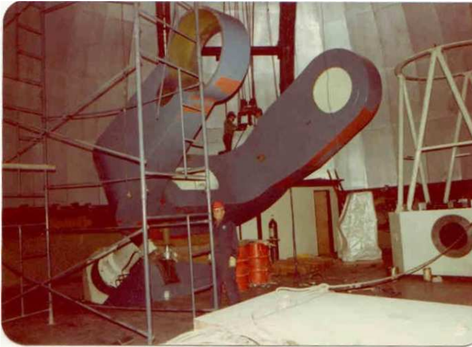
Figura 123 El Ing. Baustian transitando debajo de la horquilla ya instalada
