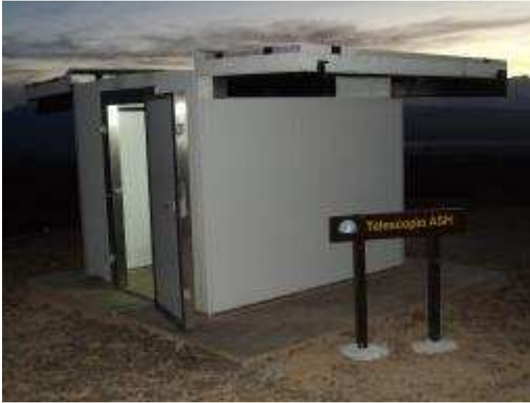
Figura 324 Albergue de techo desplegable del ASH
